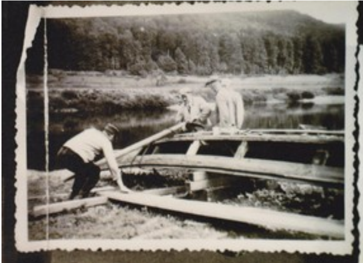
Bau eines Lattenschiffs um 1930
